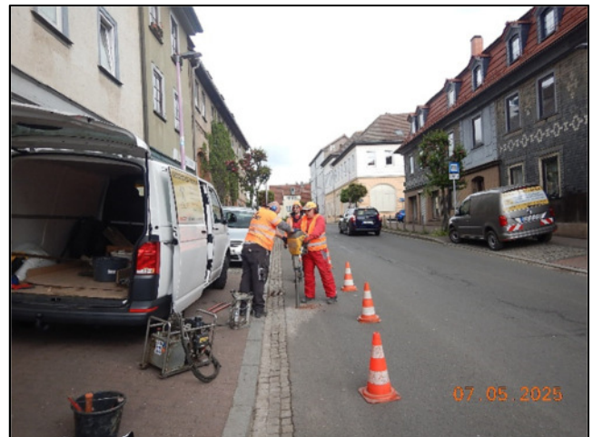
Abb.2-4: Durchführung der Kleinrammbohrungen (KRB); oben links KRB 4, oben rechts KRB 10, unten links KRB 14
